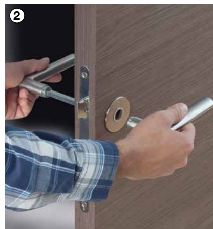
2 Sklapanje kljuk za vrata
